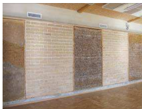
Pisé, briques de terre crue et bauge, les 3 techniques de terre utilisées en parement du mur
