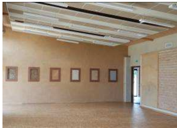
Au fond de la salle, 6 fenêtres pédagogiques viennent rappeler l'isolation en paille et les différentes étapes de finition des enduits en terre.
